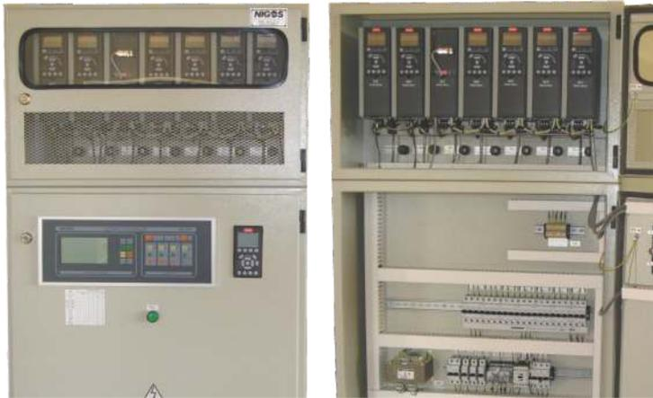
Im Befehlsansatzschrank (KRO) befinden sich die Geräte und Komponenten zur Führung und Schutz der ganzen Trocknerausrüstung. Das wichtigste Gerät ist Automat zur Steuerung des Trocknungsprozesses und es befindet sich in Abhängigkeit vom Typ des Trockners, entweder im Schrank oder daneben. KRO ist außerhalb der Trockenkammer und befindet sich in einem entsprechenden Raum.
